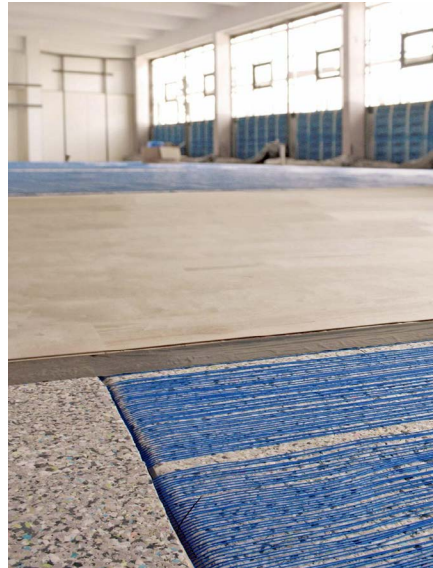
Installation einer Kapillarrohr-Fußbodenheizung
