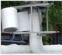
Deichbaumaschine topomover beim Verlegen eines Schlauches mit einem Durchmesser von 90 cm
