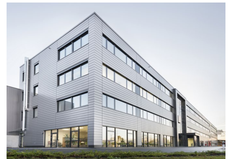
Bürogebäude in Metallleichtbauweise
