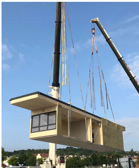
Die Module werden mithilfe von zwei Kränen abgeladen und platziert
